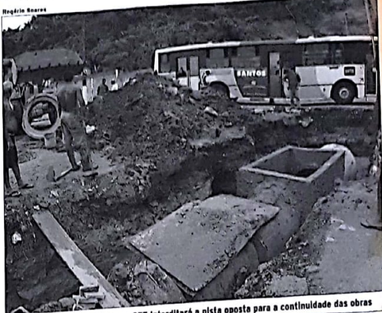
No próximo final de semana, a CET interditará a pista oposta para a continuidade das obras
