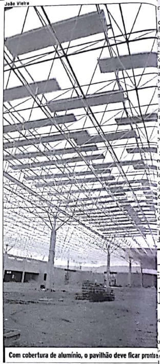
Com cobertura de alumínio, o pavilhão deve ficar pronto
